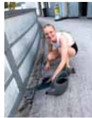
Verfugung der entstandenen Risse
